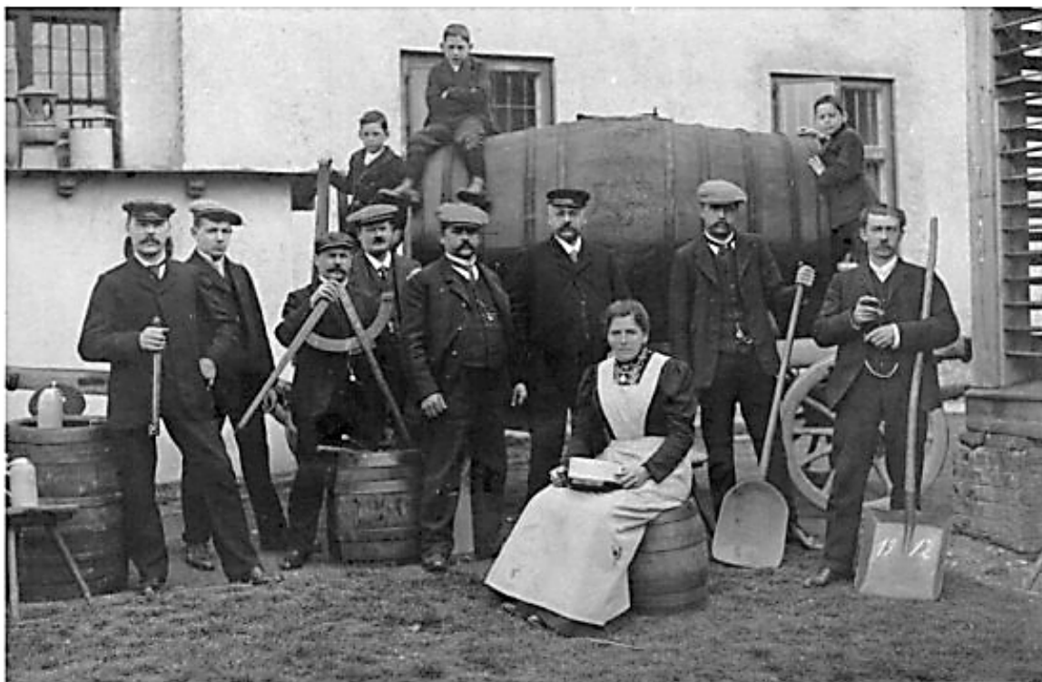
1912 wurde in der Schleißheimer Brauerei das letzte Fass Bier gebraut. Sie befand sich im Südflügel der Schwaige beim Alten Schloss Schleißheim.
